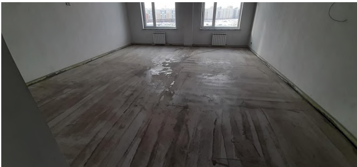
Рисунок 12 – Грунтованная поверхность
