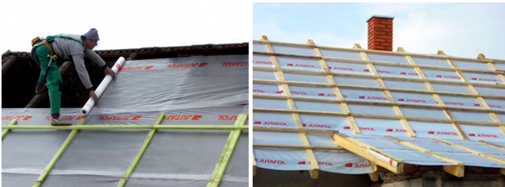
6-сурет - Гидрооқшаулағыш үлдірді төсеу
