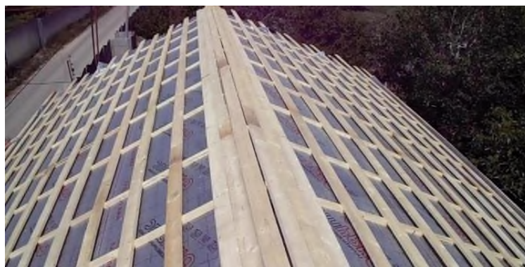
Рисунок 7 – Устройство обрешетки
