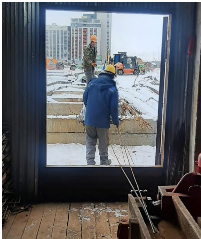
Рисунок 4 – Резка арматуры на приводном станке
