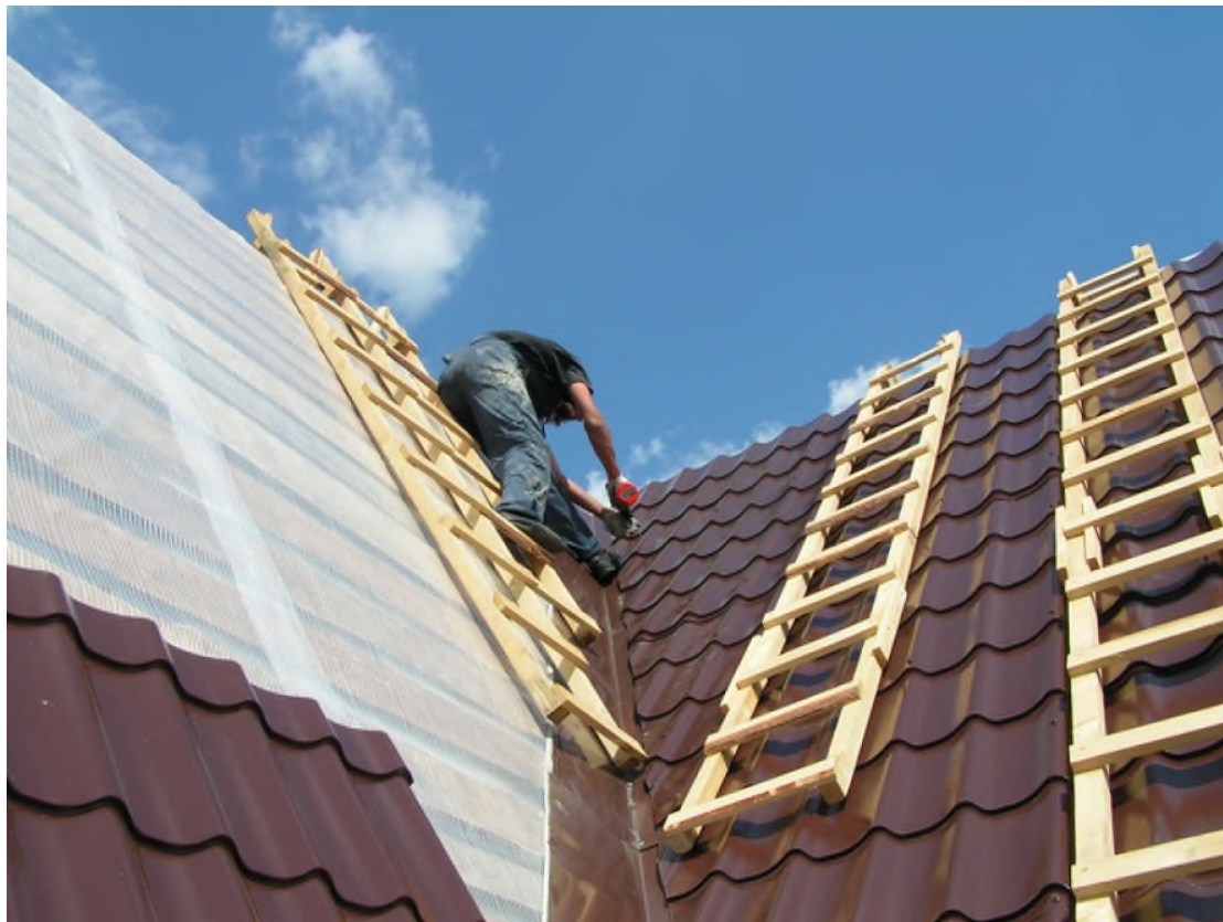
8-сурет - Металл жабынқыштан жасалған жабындарды бөлшектеу
