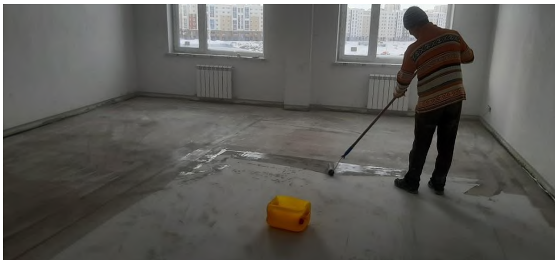
Рисунок 11 - Нанесение грунтовочного состава
