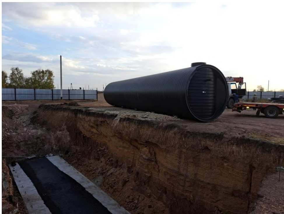
Рисунок 7 – Вариант №2 (монтаж в сухих грунтах на монолитное железобетонное основание)
