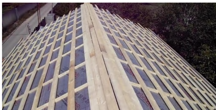
7-сурет – Торламаның құрылғысы
