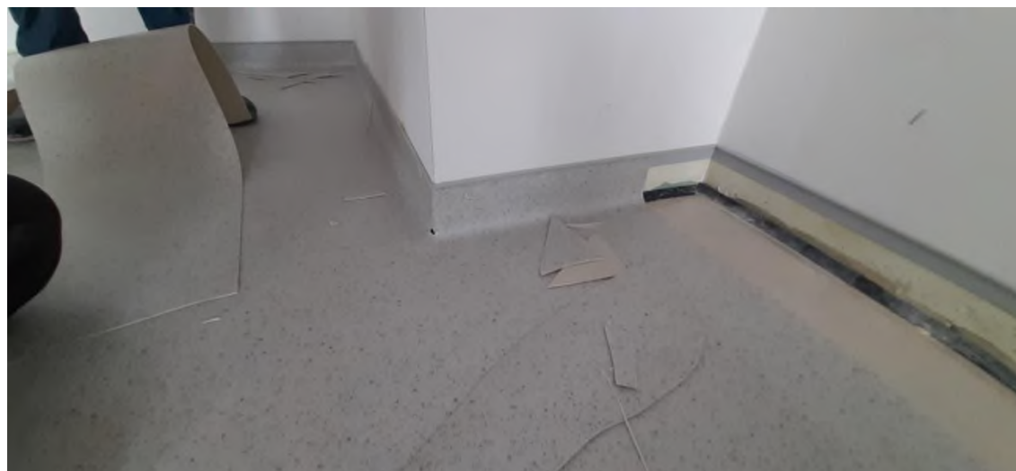
Рисунок 16 – Заводка линолеума в плинтус на стену
