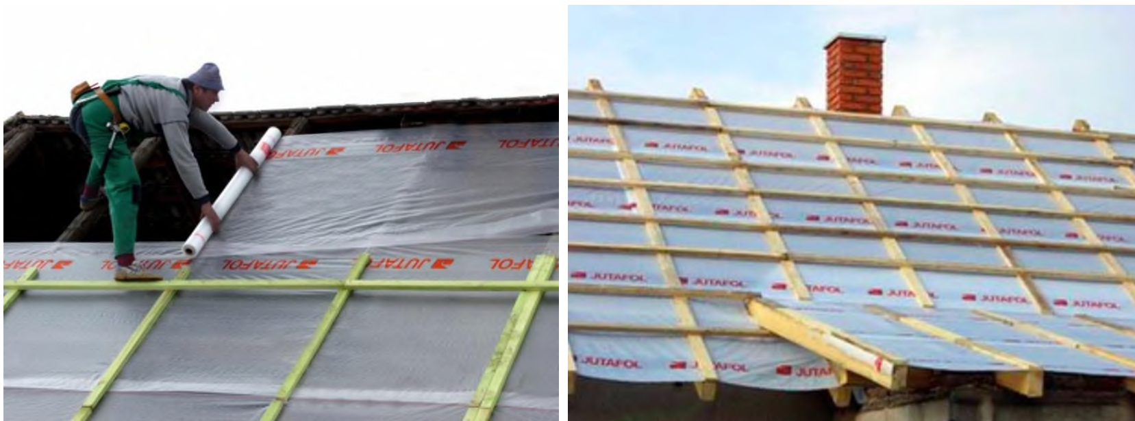
Рисунок 6 - Укладка гидроизоляционной пленки
