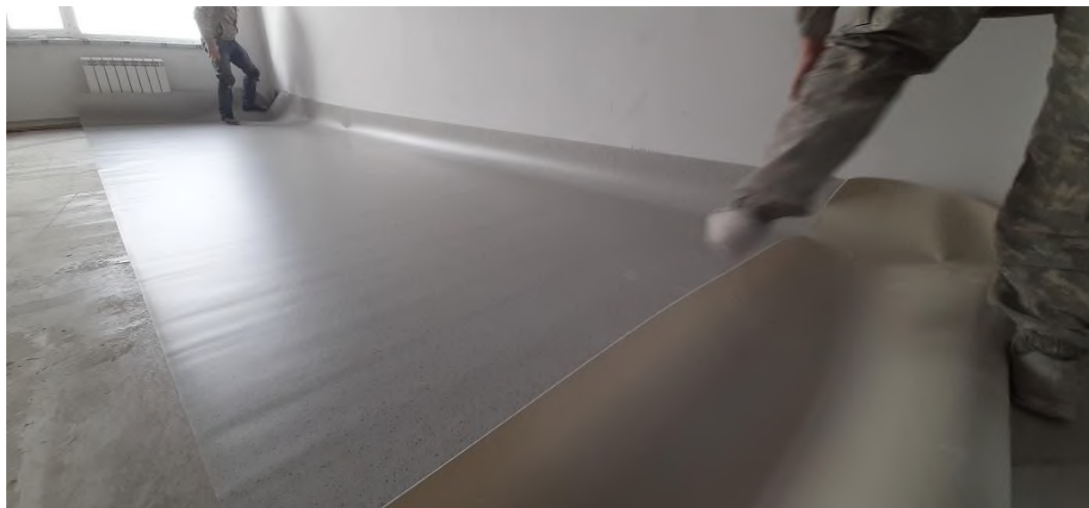
Рисунок 13 - Раскройка линолеума по размерам
