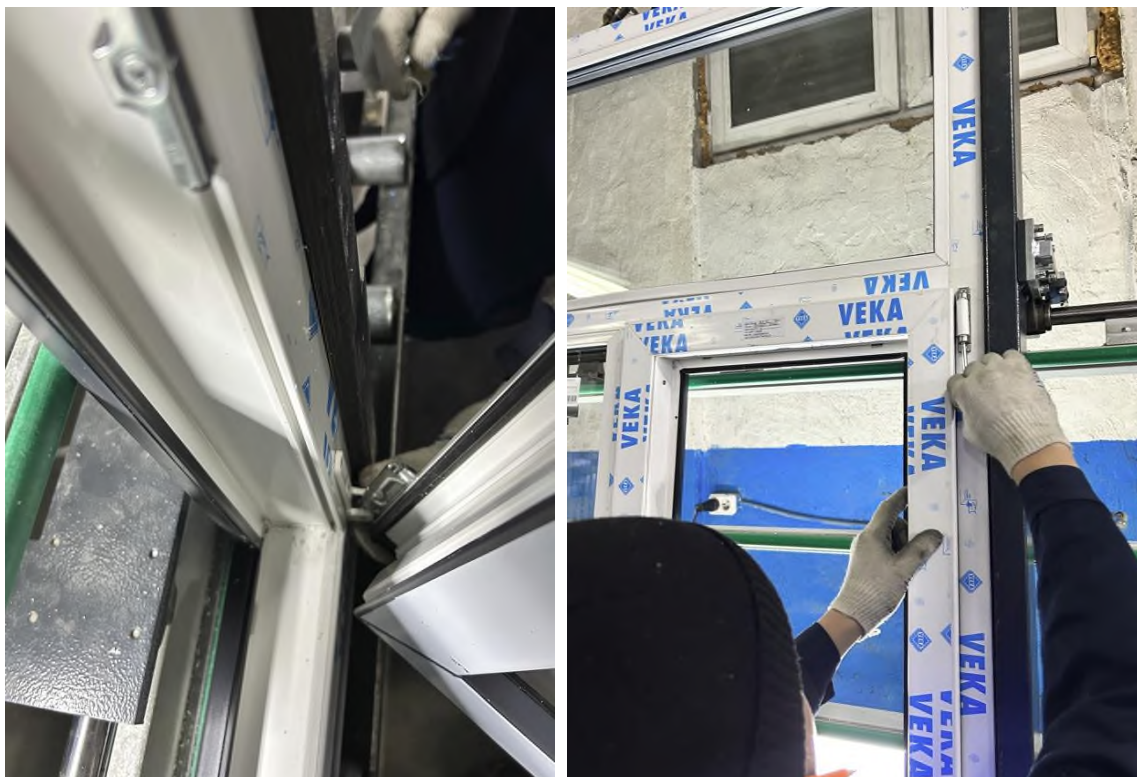
Рисунок 14 – Снятие и установка оконных и дверных петель
