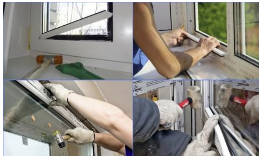
Рисунок 11 – Основные этапы извлечения и установки штапика ПВХ
