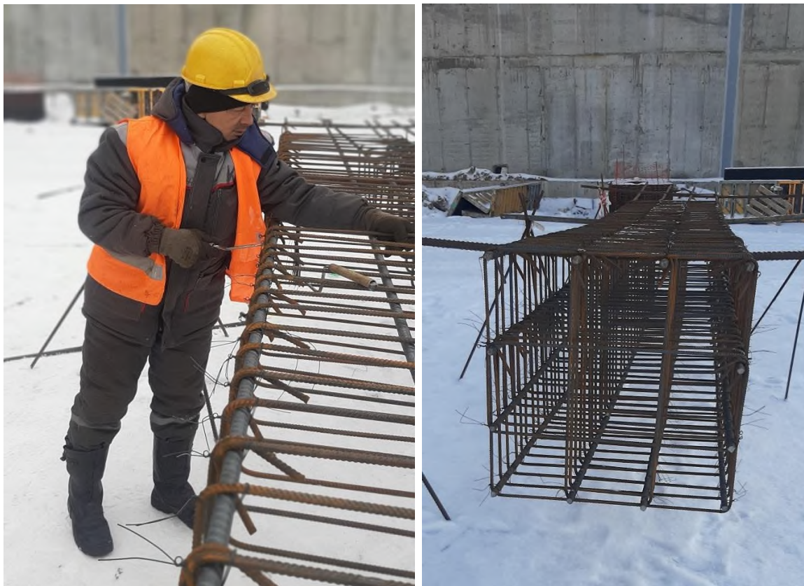
Рисунок 6 - Сборка пространственного арматурного каркаса
