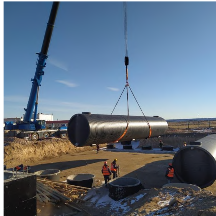
Рисунок 7 – Вариант №2 (монтаж в сухих грунтах на монолитное железобетонное основание)
