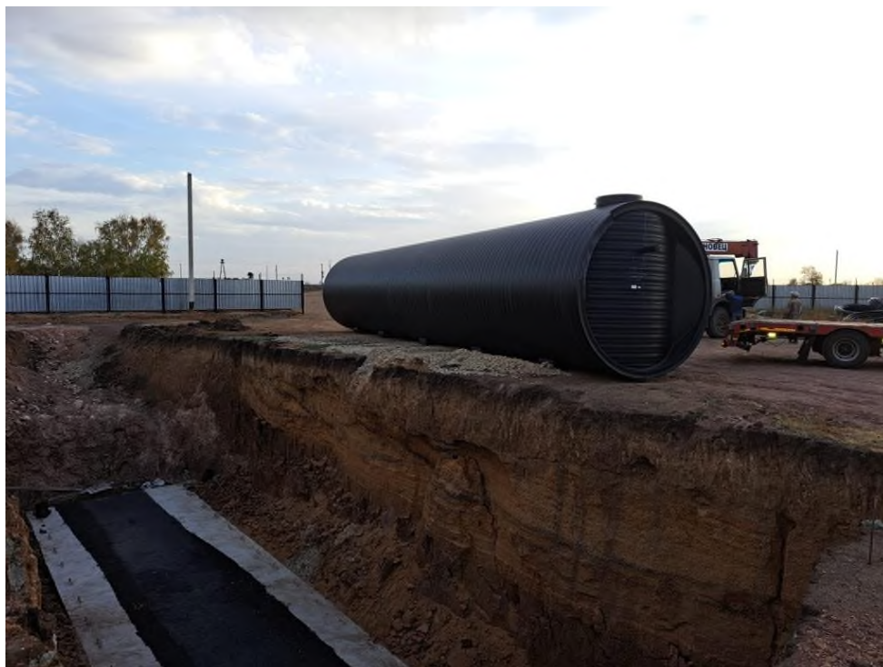
7-сурет – №2 нұсқа (құрғақ топырақта монолитті темірбетон негізге монтаждау)
