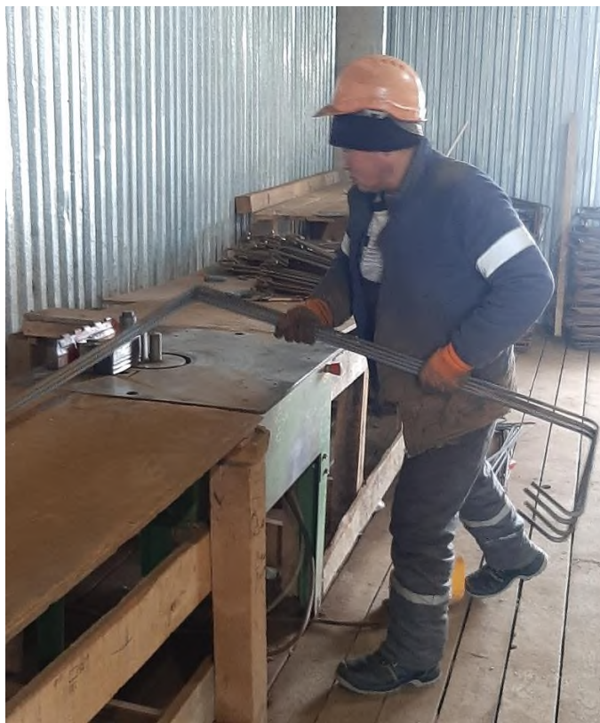
Рисунок 5 – Гнутье арматур на приводном станке
