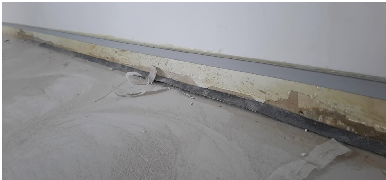
Рисунок 10 – Этапы установки коннелюрного профиля (плинтуса)
