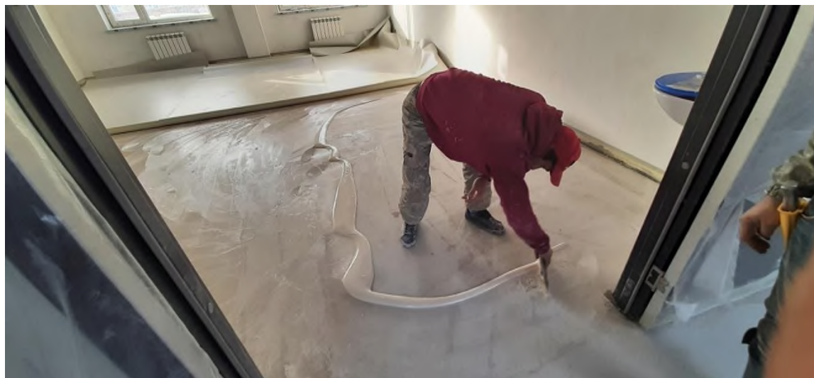
Рисунок 14 - Нанесение клея на основание пола
