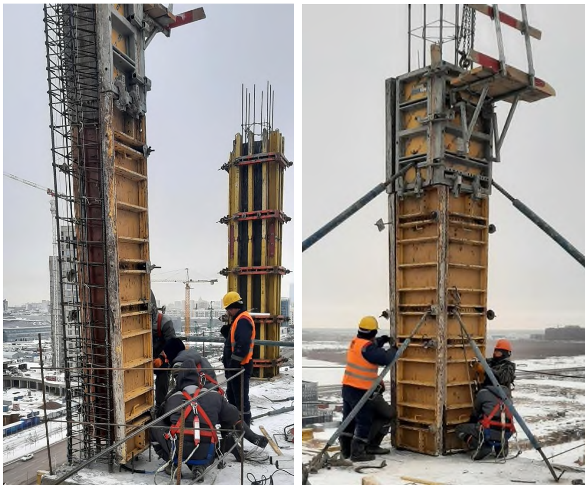
Рисунок 8 – Установка опалубки колонн
