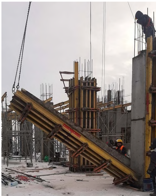
10-сурет - Бағаланаалардың қалыбын бөлшектеу
