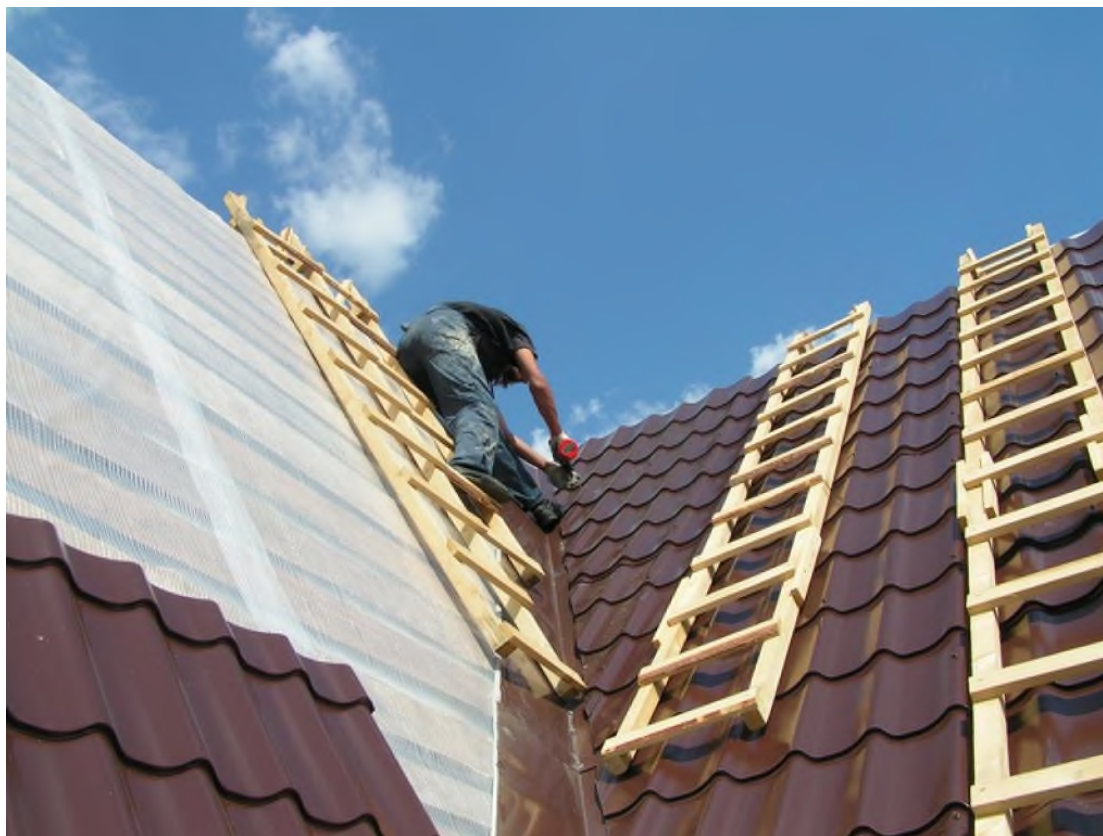
Рисунок 8 - Разборка покрытий из металлочерепицы
