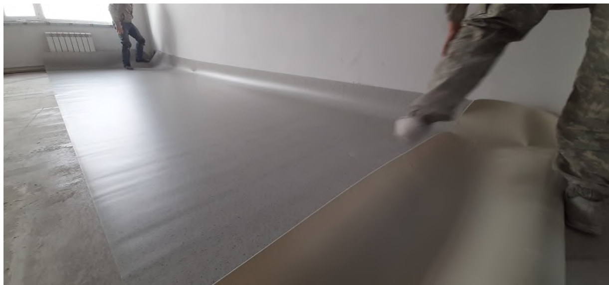
13-сурет – Линолеумды өлшемі бойынша пішу
