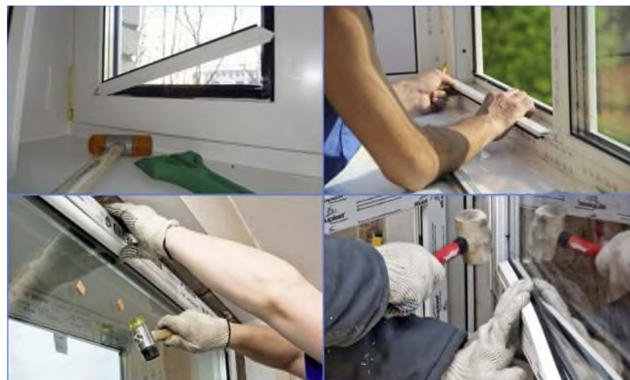
11-сурет – ПВХ штапикті алу мен орнатудың негізгі кезеңдері а – штапиктерді алу, б – штапиктерді орнату
