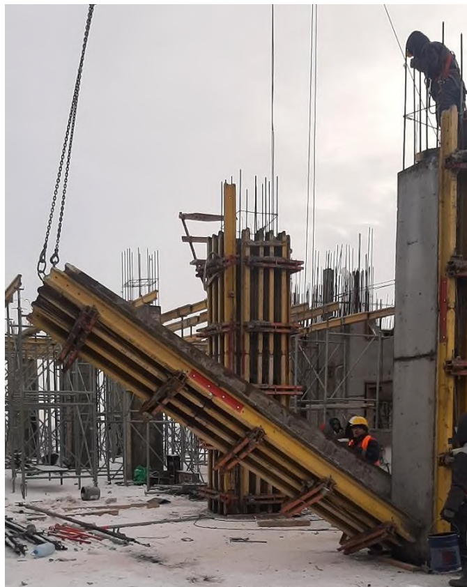
Рисунок 10 – Демонтаж опалубки колонн
