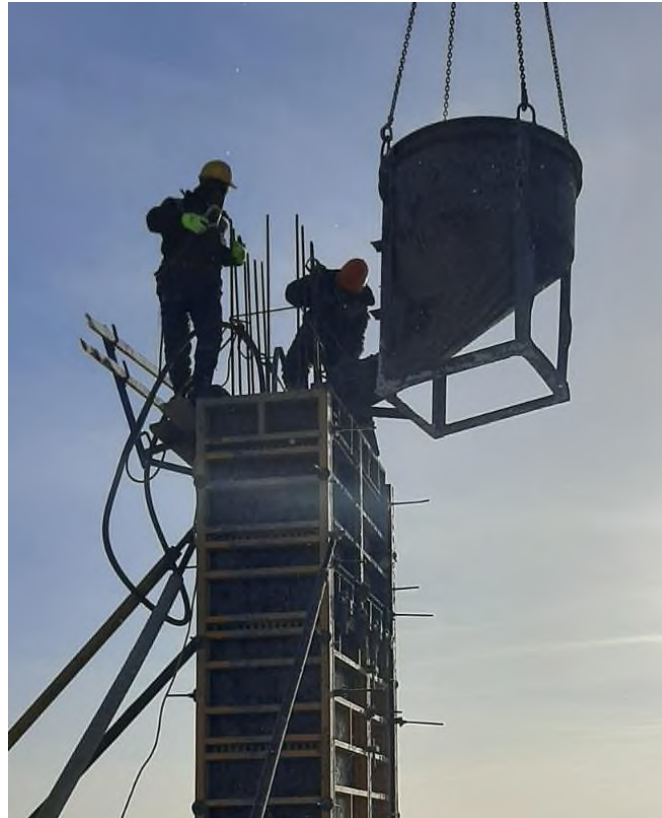
Рисунок 9 – Укладка бетонной смеси
